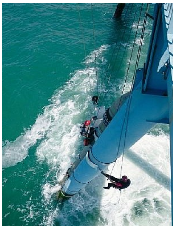
Plongeurs et alpinistes ont participé aux travaux. PHOTO ANNIE PEYRAS
