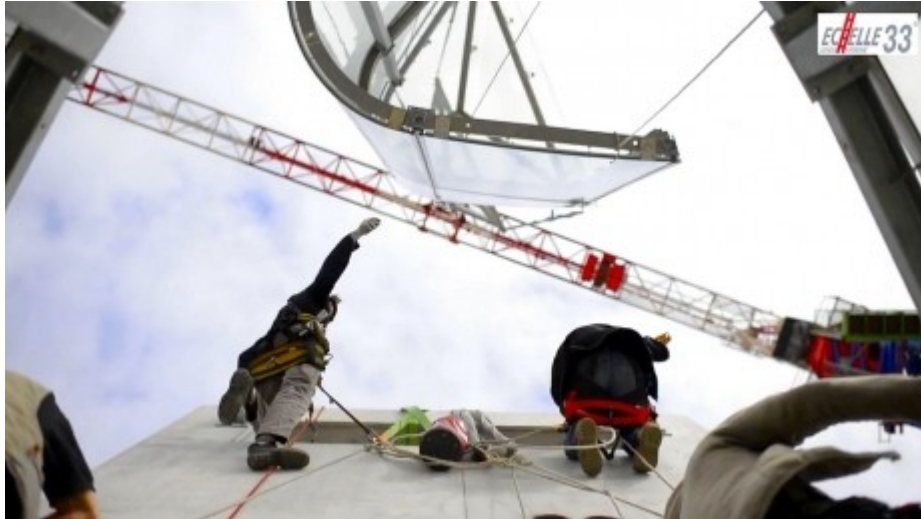
Les ouvriers d'Adrénaline 33 pendant la construction du Pont © Radio France
