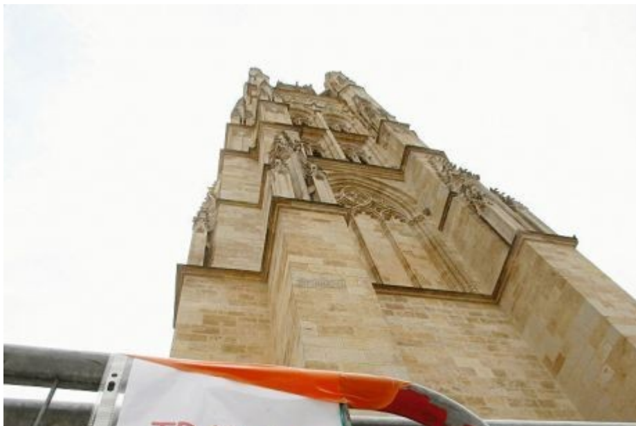
Des filets vont envelopper les deux terrasses de la tour. photo f. c.
